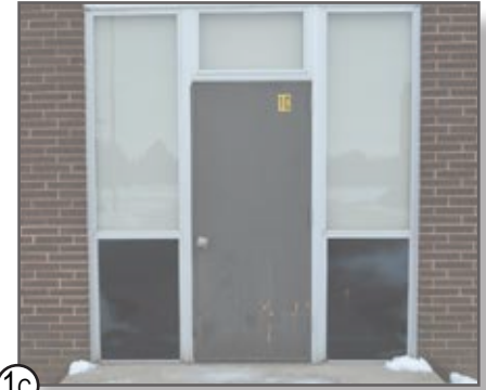
1C HOLLOW METAL DOOR & ALUMINUM FRAME
